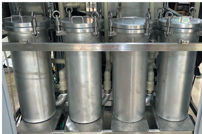
Рис. 4. Внутренняя система рециркуляции деионизированной воды в установках PurBest Hydro-clean
